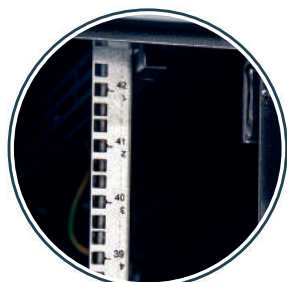
Numeracja profili RACK ułatwiająca montaż
